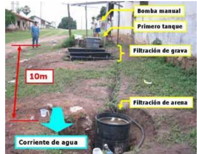
Use of natural slope, pour in sand filter
