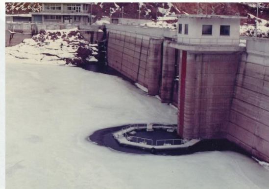
図18 厳寒期の取水口
