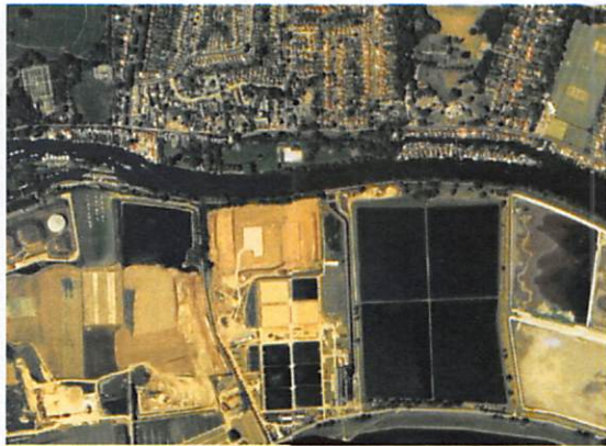
ロンドン市 Ashford Common 浄水場
