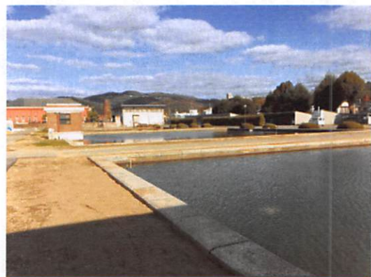
岡山市 三野浄水場
