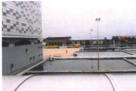
パリ市 Ivry 浄水場
